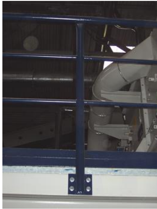
Rys 6: Mocowanie poręczy
