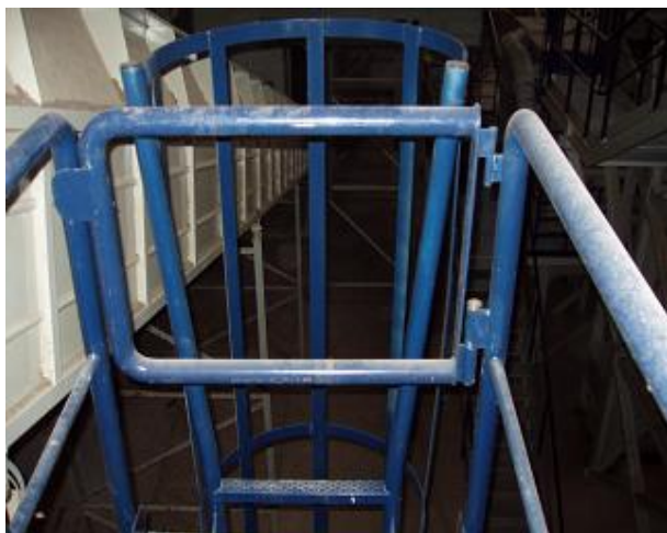
Rys. 3: Przykład zabezpieczenia przed wypadnięciem schodach
