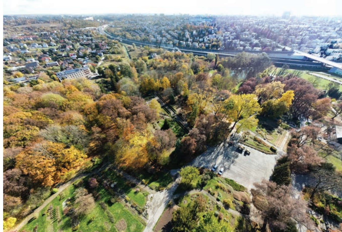
Widok na redutę i dolinę Czechówki.
